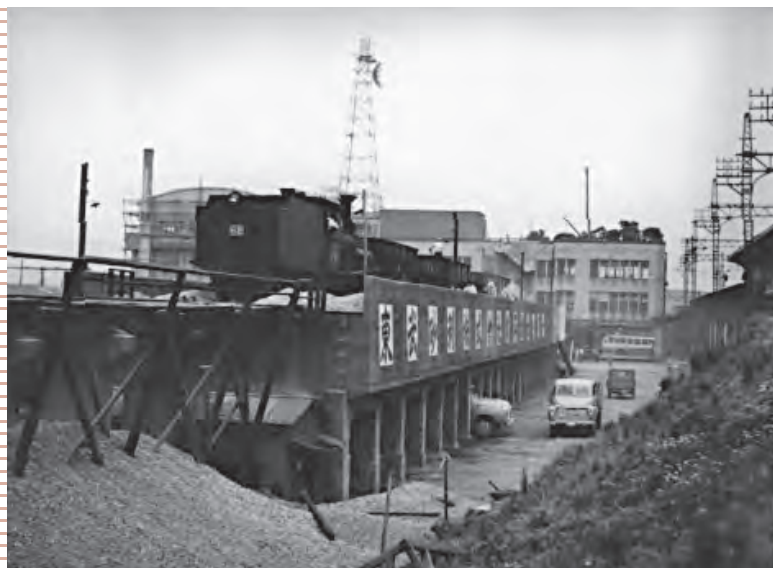
業平橋駅構内 コンクリート製ホッパー線（花上嘉成氏撮影 東武博物館提供）
